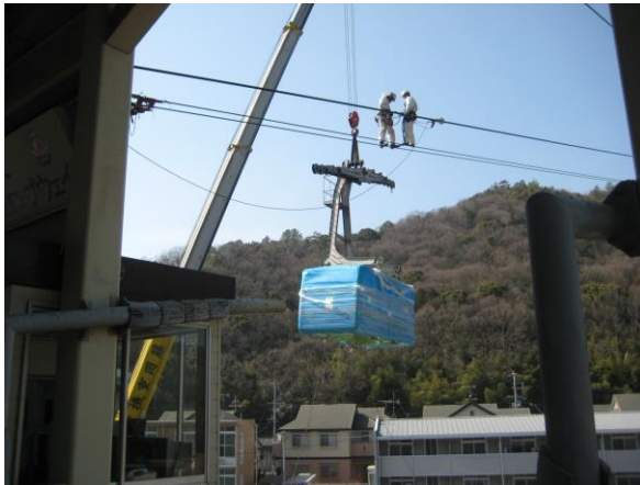
【客車更新作業】
